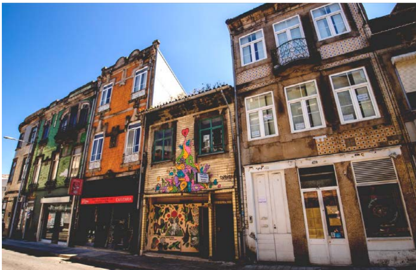
Figura 3. Edifícios em diferentes estados de conservação no Bonfim. Fonte: Juliano Mattos.
